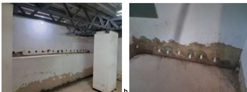
Fotografía 109: a. Perforación del muro para mejoras de desagüe ; b. Instalación de sistema de desagüe por medios de codos en tubo PVC
