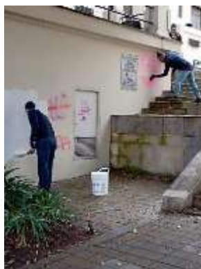
Fotografía 366: grafitis en la fachada calle 24
