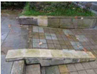
Fotografía 359: reemplazo de piedra muñeca en la rampa exterior de la BNC. 24/06/2025.
