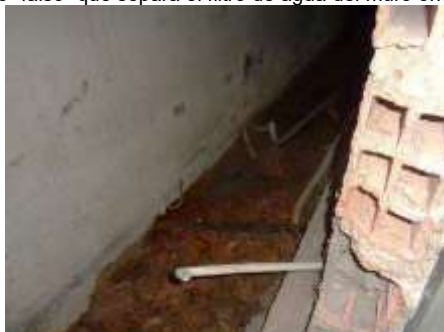
Imagen 13: empozamiento de agua en el filtro de agua de reserva de prensa.
