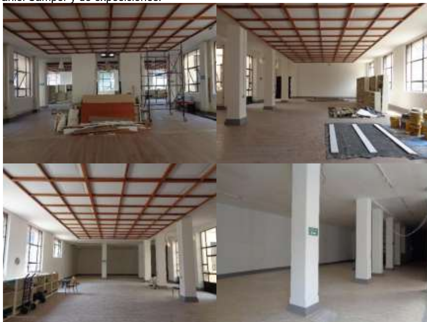
Fotografía 133: foto documentación de referencia de la sala Daniel Samper y sala de exposiciones antes de la remodelación de pisos, techos y movimientos de estanterías.
