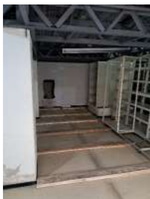
Proceso de desmonte de estanterías aledañas al muro oriental el día 14 de agosto
