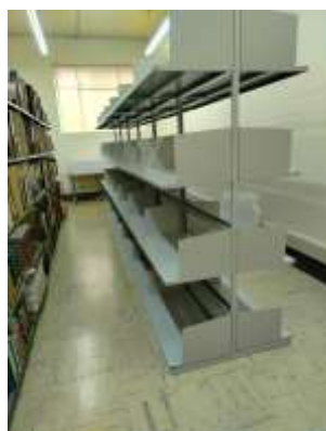
b. Finalización de estantería
