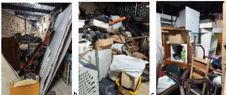
Fotografía 169: fotografías en 2025 de la rancha, a. Acumulación de material en la rancha; b. Acumulación de objetos foráneos en la rancha; c. Estado de la rancha durante la visita del 26 de junio del 2025.
