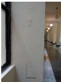
Fotografía 165: a. Ubración de calas protegidas mediante cinta de enmascarar
