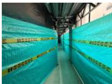
Imagen 106: Resultado final del cubrimiento con plásticos y poli sombras de las estanterías del depósito de prensa.
