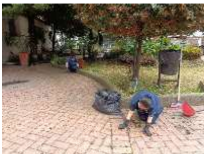
Fotografía 357: proceso de deshierbado manual del parqueadero.
