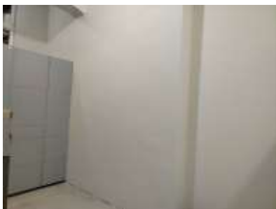
finalización de reparo de la grieta
