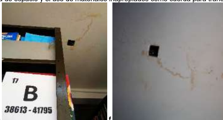
e. Detalle del techo con indicadores de humedad frente a la estantería 17; f. Detalle de la extensión de la humedad del techo en bibliográfico (zona suroccidental).
