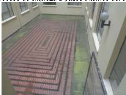
Imagen 83: fotografía general del patio suroccidental.
