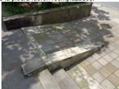
Fotografía 358: faltantes de piedra muñeca en la rampa exterior de la BNC. Imagen capturada el 17/enero/2025.
