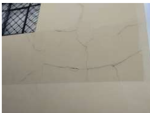
Fotografía 374: a. Grietas y faltantes en fachada norte; b. Grietas y faltantes occidental de la biblioteca después del proceso de repintado de la Biblioteca en meses anteriores.
