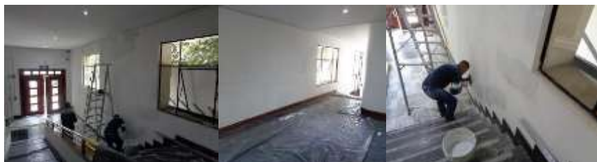
Imagen 15: proceso de resane, pañetado y pintura de la pared occidental del sótano, frente al Mosaico y el Auditorio Germán Arciniegas.
