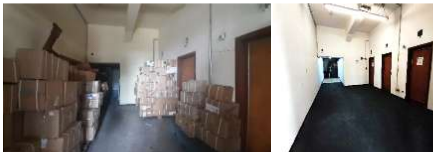
Imagen 55: a. Puerta garaje antes; b. Puerta garaje después de los procesos de mantenimiento realizados en mayo.
