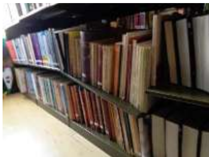
Fotografía 232: detalle del entrepaño que se desplomó y está deteriorando la colección.
