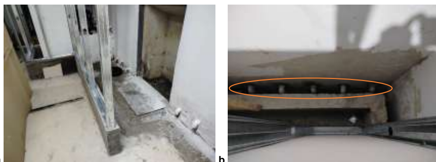
Fotografía 121: a. Instalación de estructuras de metal con drywall; b. Evidencias del sistema de desagüe con lloraderos que se denotan en la zona roja.
