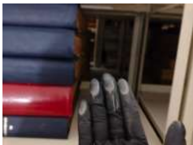
Pulverulencia en mezanine derivados de la obra
