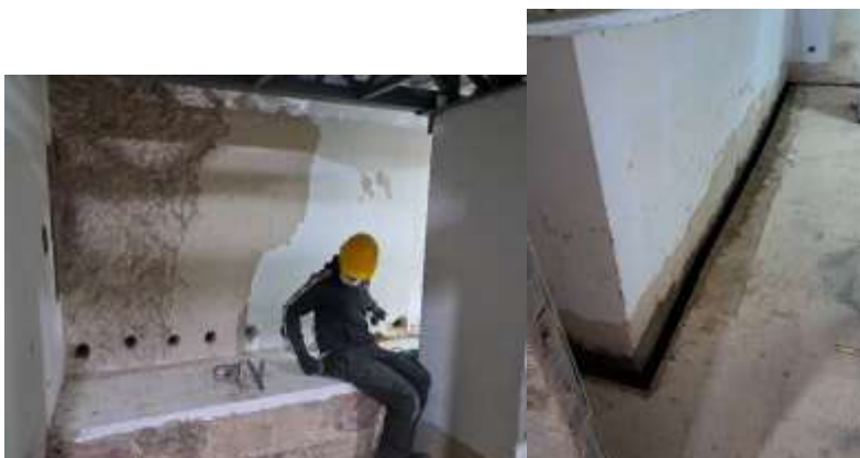
Fotografía 108: Eliminación de pintura y revoque; Fotografía 110: Canal de drenaje alrededor del muro oriental para mejorar sistema de desagüe.
