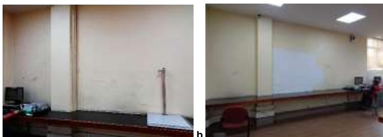
Fotografía 183: a. Muro sur con problemas de humedad antes de la reparación; b. Muro sur después de los procesos de mantenimiento en la sala de consulta Hemeroteca.
