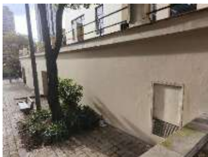
Fotografía 369: fotografía final de la fachada sur del edificio -después de repintada-.
