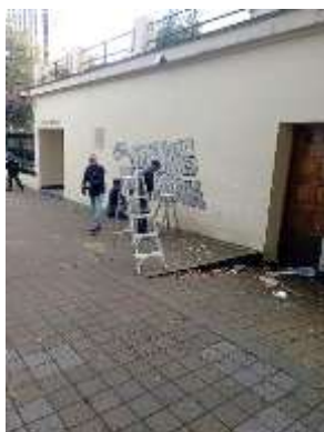
Fotografía 365: grafitis en la fachada calle 24
