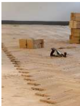
Detalle de la instalación y patrones del piso de madera de sala de Exposiciones.
