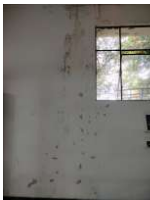
Fotografía 125: a. Ubicación general de la humedad, al lado de la entrada hacia corredor al auditorio general Germán Arciniegas; b. Fotografía de detalle de humedad.
