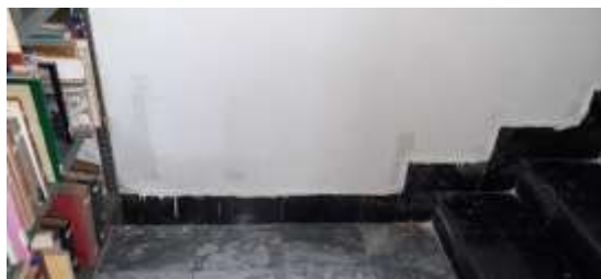
Imagen 8: muro sur de la reserva Vázquez
