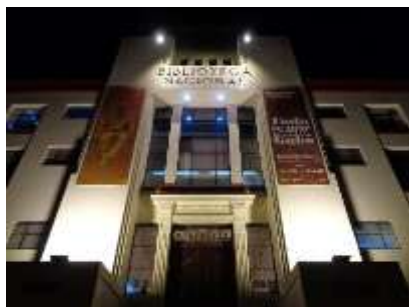
Fotografía 352: sistema de iluminación finalizado y actualizado en la fachada.
