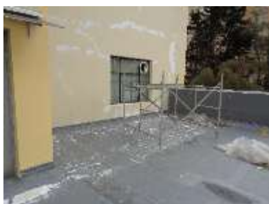
Fotografía 305: proceso de mantenimiento de fachadas en cuarto piso.
