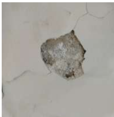
Fotografía 125: a. Ubicación general de la humedad, al lado de la entrada hacia corredor al auditorio general Germán Arciniegas; b. Fotografía de detalle de humedad.
