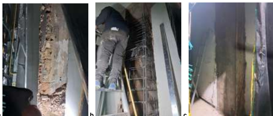
Fotografía 111: proceso postura columna estructural. a. Eliminación del muro que presentaba la grieta por medio de pulidora; b. Instalación de la estructura de columna; c. Finalización de vertido de mezcla de concreto para la reconstrucción de la columna.
