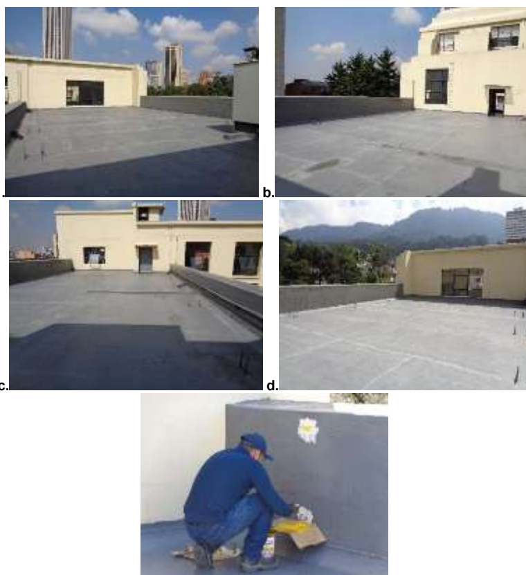
Fotografía 294: terrazas de la biblioteca nacional. a. terraza nororiental; b. terraza suroriental; c. terraza suroccidental; d. Terraza noroccidental; Proceso de limpieza y pintado de los puntos de sujeción que se ubican en las terrazas
