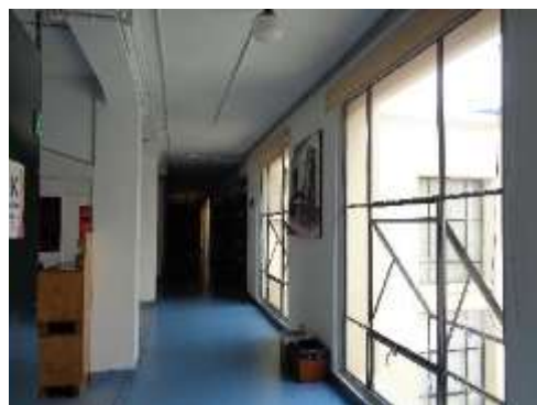
Fotografía 317: fotografía general de las ventanas y persianas abiertas al ingreso a la reserva.
