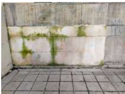
Fotografías 373: a. Graffitis en la zona de las escaleras en costado sur a la entra de la biblioteca; b. Crecimiento de algas en las losas de piedra muñeca previamente reemplazadas.
