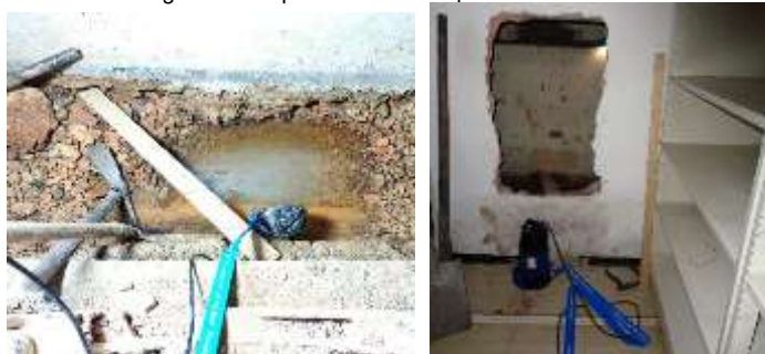
Extracción de agua del filtro mediante bomba; b. Detalle del proceso de extracción; c. Detalle del filtro y electrobomba después del proceso de extracción de agua; d. Fotografía final del proceso; e. Ruta por la cual sacaron la manguera de desagüe
