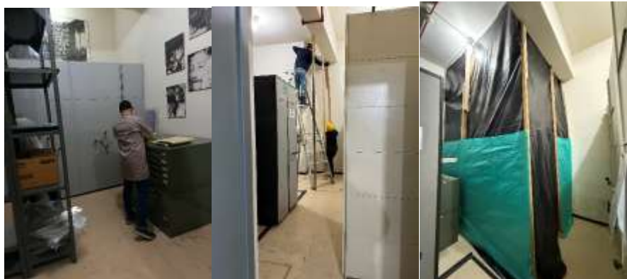
b. Movimiento de estantería y mueble en microfilm el día 15 de agosto; c. Espacio despejado y dispuesto para la reparación de la grieta; elaboración de una estructura en madera con plástico y poli sombra en el deposito microfilm
