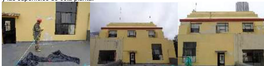
Vista general costado oriental del altílo; b. vista general costado occidental del altílo; c. Proceso de impermeabilización, resane y mantenimiento de fachada
