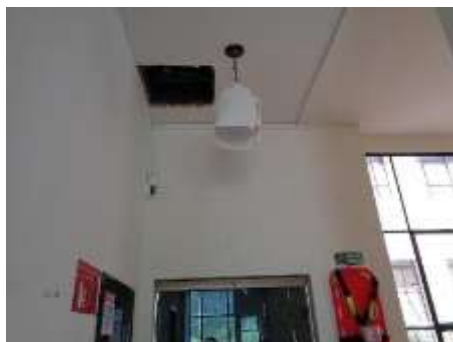
Fotografía 130: zona de acceso al entre techo del primer piso, para hacer cambio y seguimiento de los tubos del agua.
