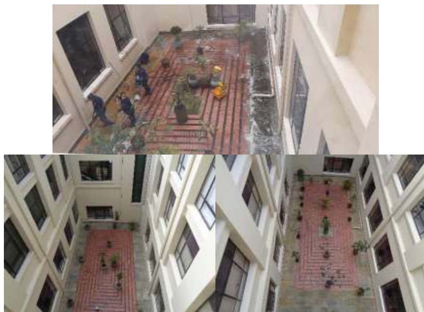
Fotografía 135: fotografías del proceso de lavado de patios orientales mediante maquina y el estado de las terrazas, después de la limpieza (mecánica).
