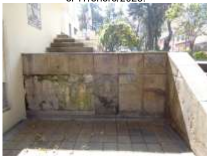
Fotografía 358: faltantes de piedra muñeca en la rampa exterior de la BNC. Imagen capturada el 17/enero/2025.
