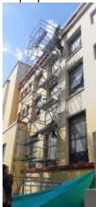
Fotografía 347: detalle proceso de pintura y mantenimiento de la fachada.
