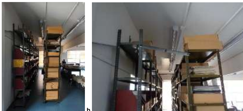
Fotografía 314: a. Estanterías antes de la instalación de barras de fijación; b. Estantería después de la instalación de las barras de fijación el 17 de junio de 2025.
