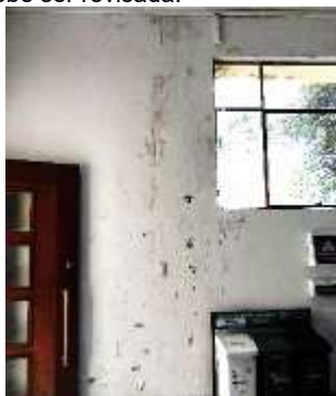
Imagen 54: condición actual del muro reparado
