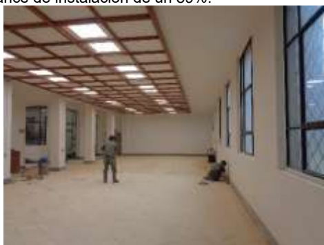
Fotografía 144: pulido y finalización del fijado del piso (Sala de consulta Daniel Samper Ortega y Sala de Exposiciones).
