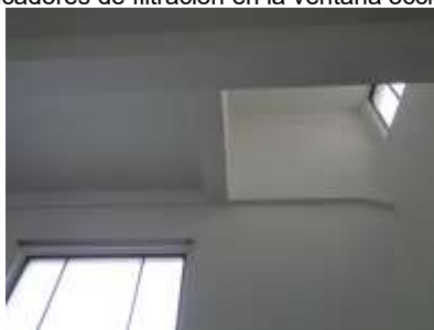
Detalle de ventana occidental de la cafetería del 4to piso
