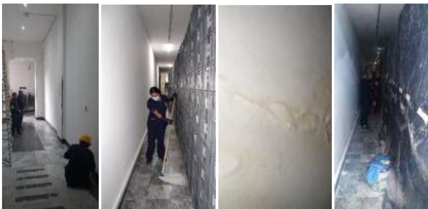
Figura 1: procesos de mantenimiento y limpieza en corredores y reserva Vásquez; Limpieza de pisos dentro de la reserva; limpieza y mantenimiento de corredores; identificación del deterioro del muro norte de la reserva Vásquez; proceso de resane muro norte.
