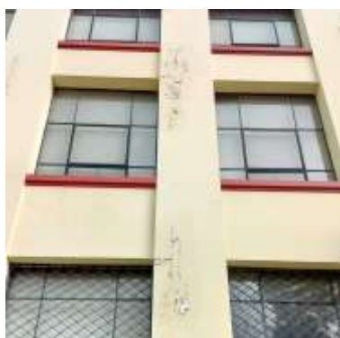
Fotografía 374: a. Grietas y faltantes en fachada norte; b. Grietas y faltantes occidental de la biblioteca después del proceso de repintado de la Biblioteca en meses anteriores.
